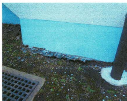
5号棟東階段脇
