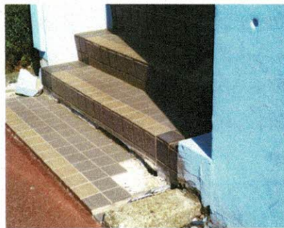
7号棟東階段 タイル、目地
