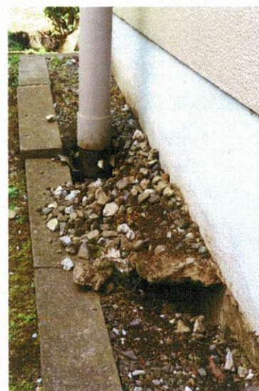
4号棟東側雨水管切断
