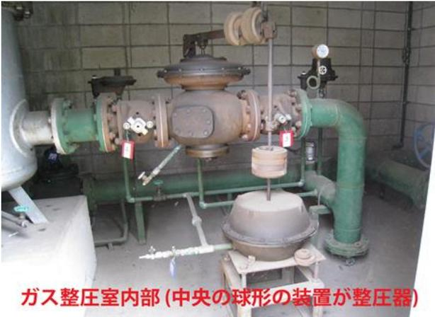
ガス整圧室内部 (中央の球形の装置が整圧器)
