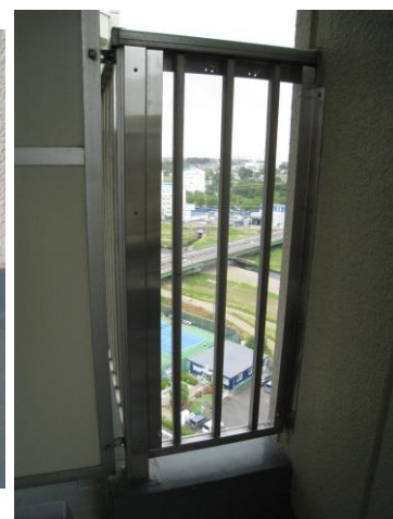
透明ポリカーボネート板をステンレス型板で保持(写真は一部)
