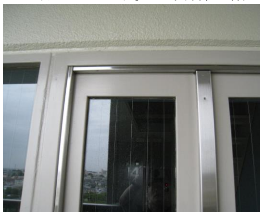
子扉の上側(外側より): 子扉の周りにゴムシールを内装したステンレス型枠材を装着
