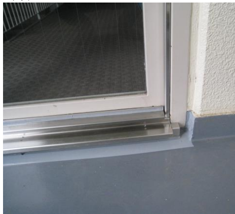
親扉の下側(外側より): ゴムシールを内装した型枠材を装着
