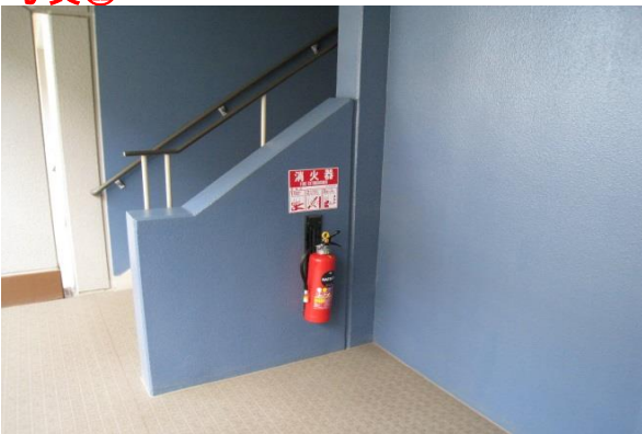
4号棟（エレベーター非停止階）
