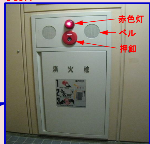
火災報知設備（全階段室の1～14階および地下駐輪場入口）
