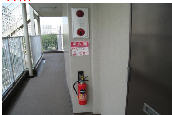
5号棟（全開放廊下東西各1箇所）
