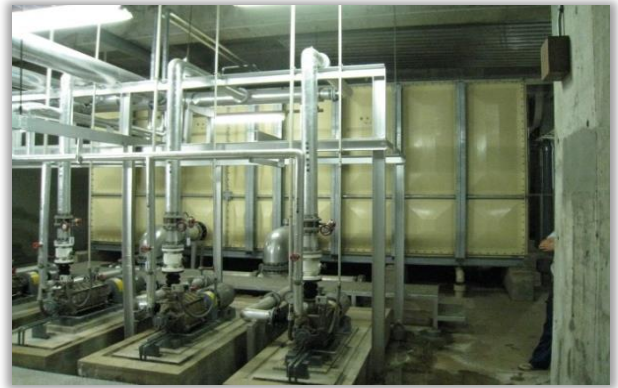
給水プラント：前方にポンプと後方に受水槽
