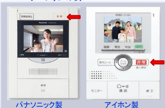
写真8 更新用警報ボタン(赤矢印)付きインターフォンの例
