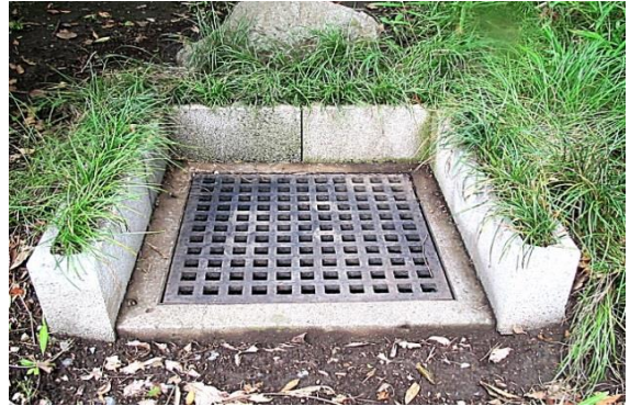
ブロックとにジャノヒゲを併用した土留め対策
