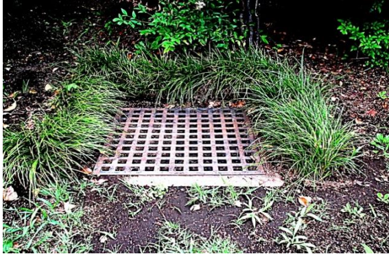
雨水桝の周囲にジャノヒゲを植えた土留め対策
