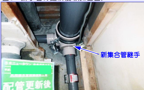
図3 排水管の更新後(第2日目)
