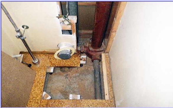
図1 排水管付近の内装の解体(第1日目)
