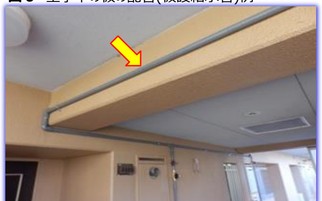
図6 工事中の仮の配管(仮設給水管)例
