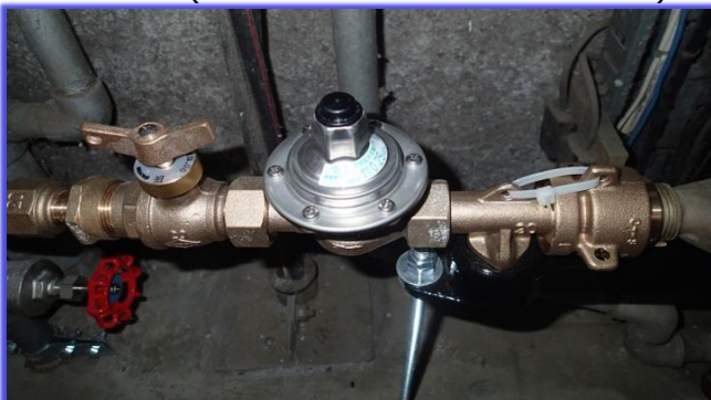
図7 減圧弁 (1号棟の実例、断熱工事前の写真)
