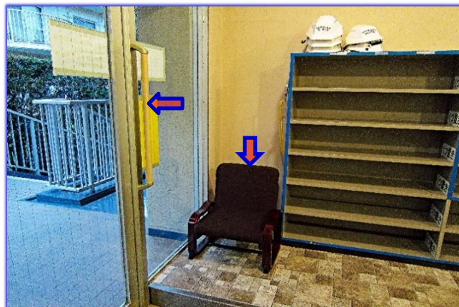
図2 玄関内の手摺と椅子
