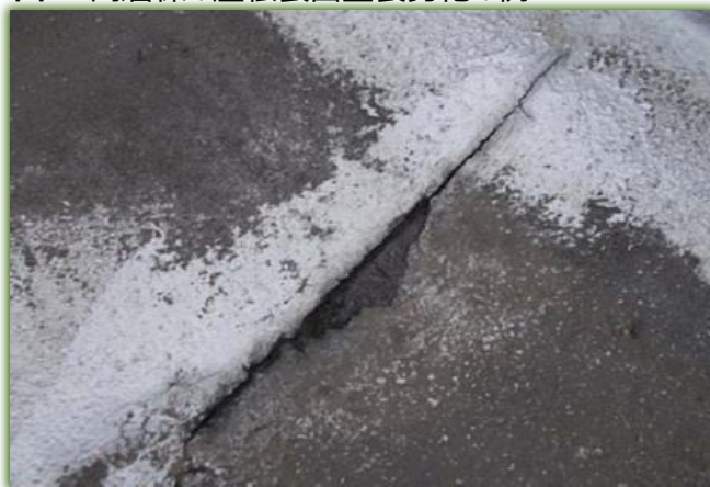
図2 高層棟の屋根表面塗装劣化の例
