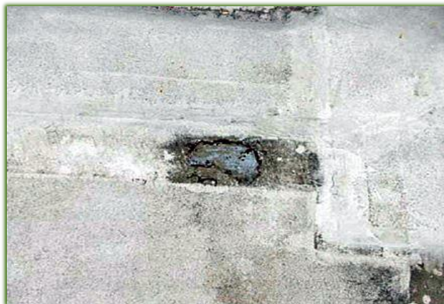
図2 高層棟の屋根表面塗装劣化の例
