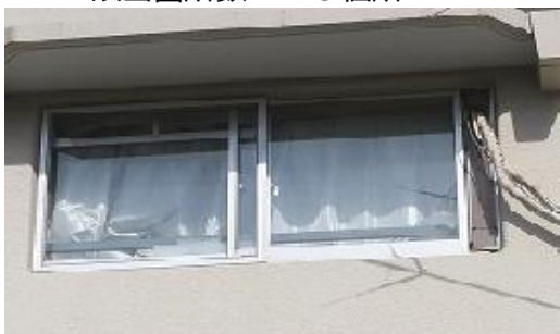
エアコン配管の現状
