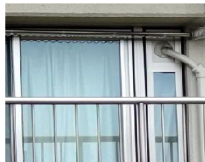
袖パネル付きに変更後のエアコン配管（参考事例）
